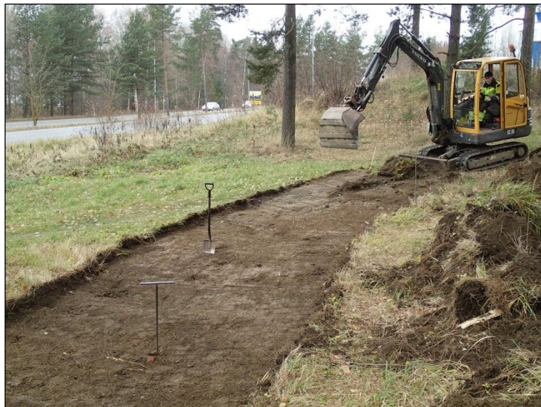
Puistokäytävän keskiosaa kaivettuna määräsyytyteen
